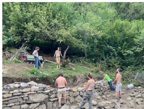
Chantier collectif : construction d'un mur en pierres sèches lors de la Fête des Possibles, septembre 2024
